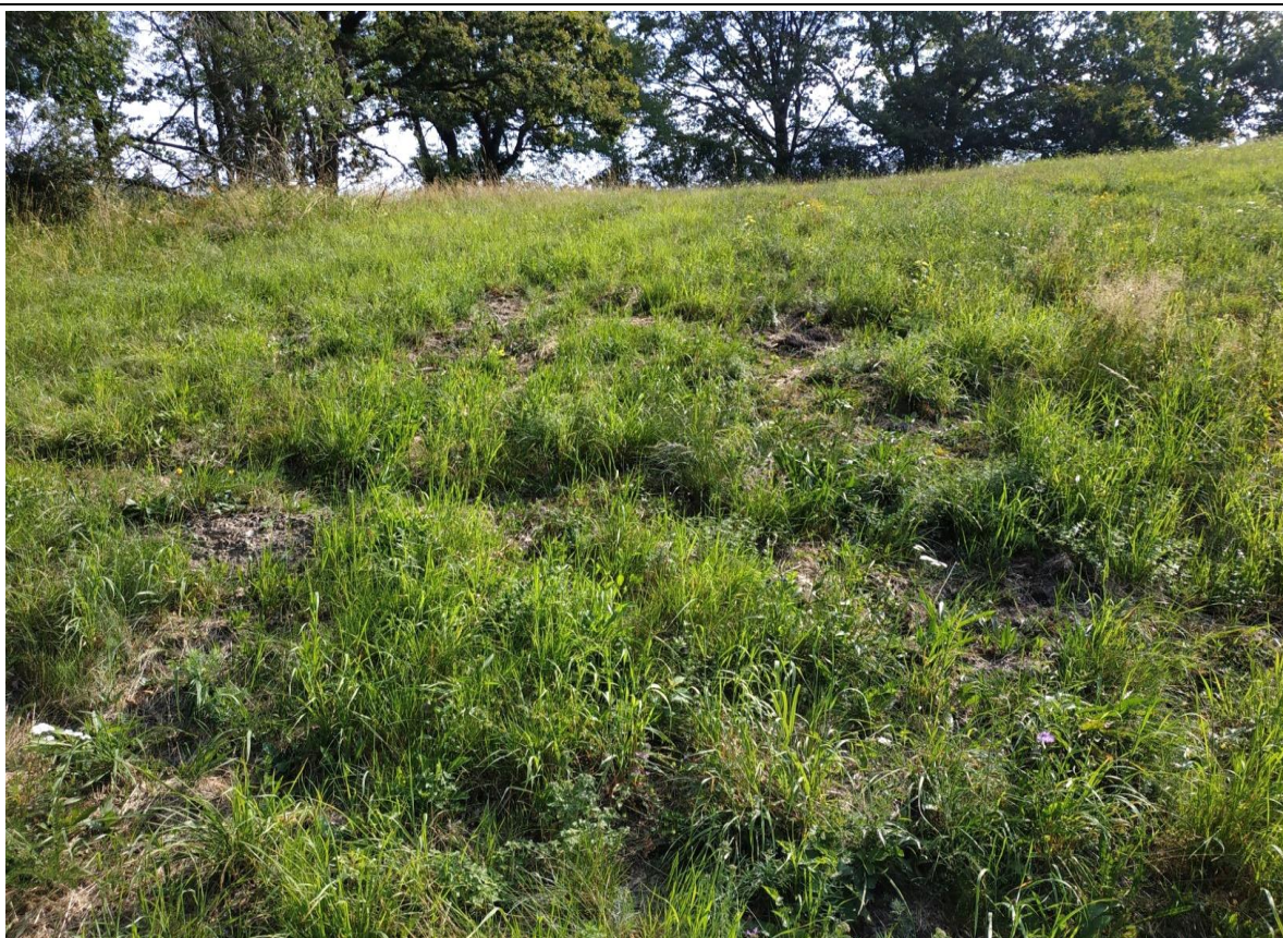
Projevy plíživé eroze ve svrchnější části svahu; vlivem vody dochází k tvorbě rýh (červenec 2019)
