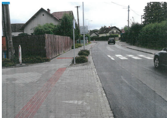
rekonstrukce - chodník od ZŠ po Rychtu - I etapa
