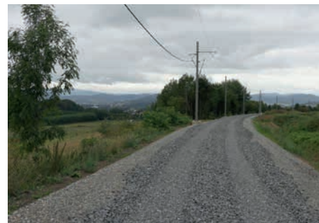
Stavba trati srpen 2022
