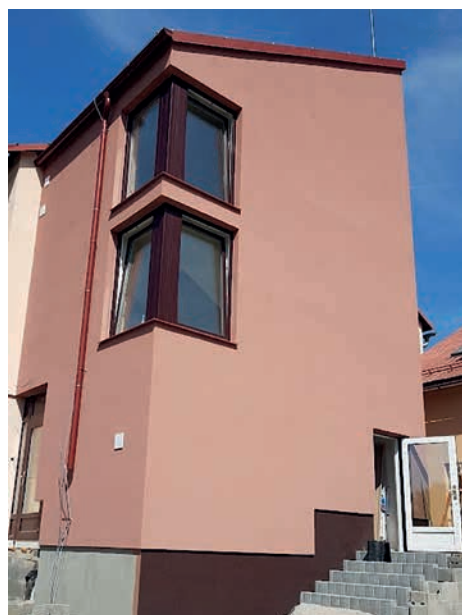
Požární únikové schodiště dolní MŠ
