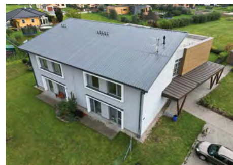
Střecha DPB Nový Malín určená pro instalaci panelů FVE.
