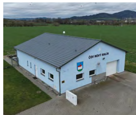
Střecha ČOV Nový Malín určená pro umístění panelů FVE
