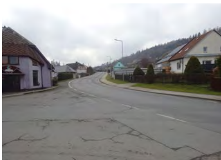
Rekonstrukce vodovodního řadu ve směru na Hrabíšín
