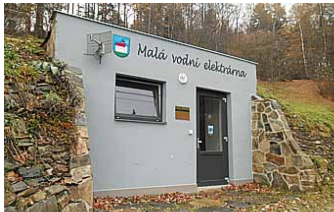
Malá vodní elektrárna
